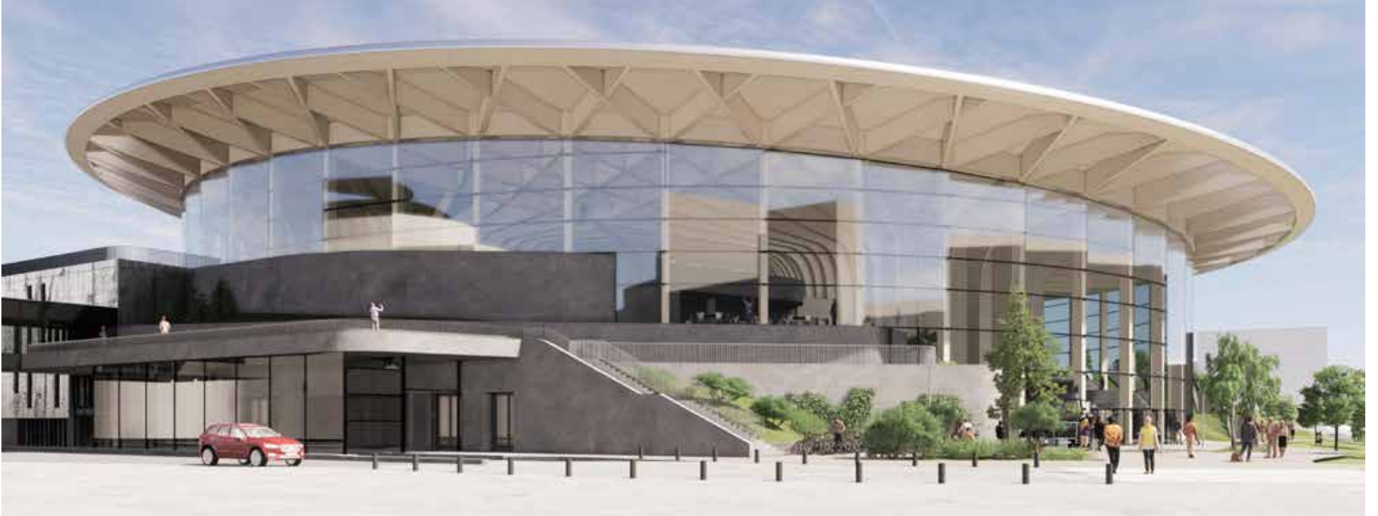
Die Volvo-World in Göteborg ist nur eines von vielen Großprojekten aus Holz, die durch ihre Form bestechen und von Wiehag Timber Construction errichtet werden.
