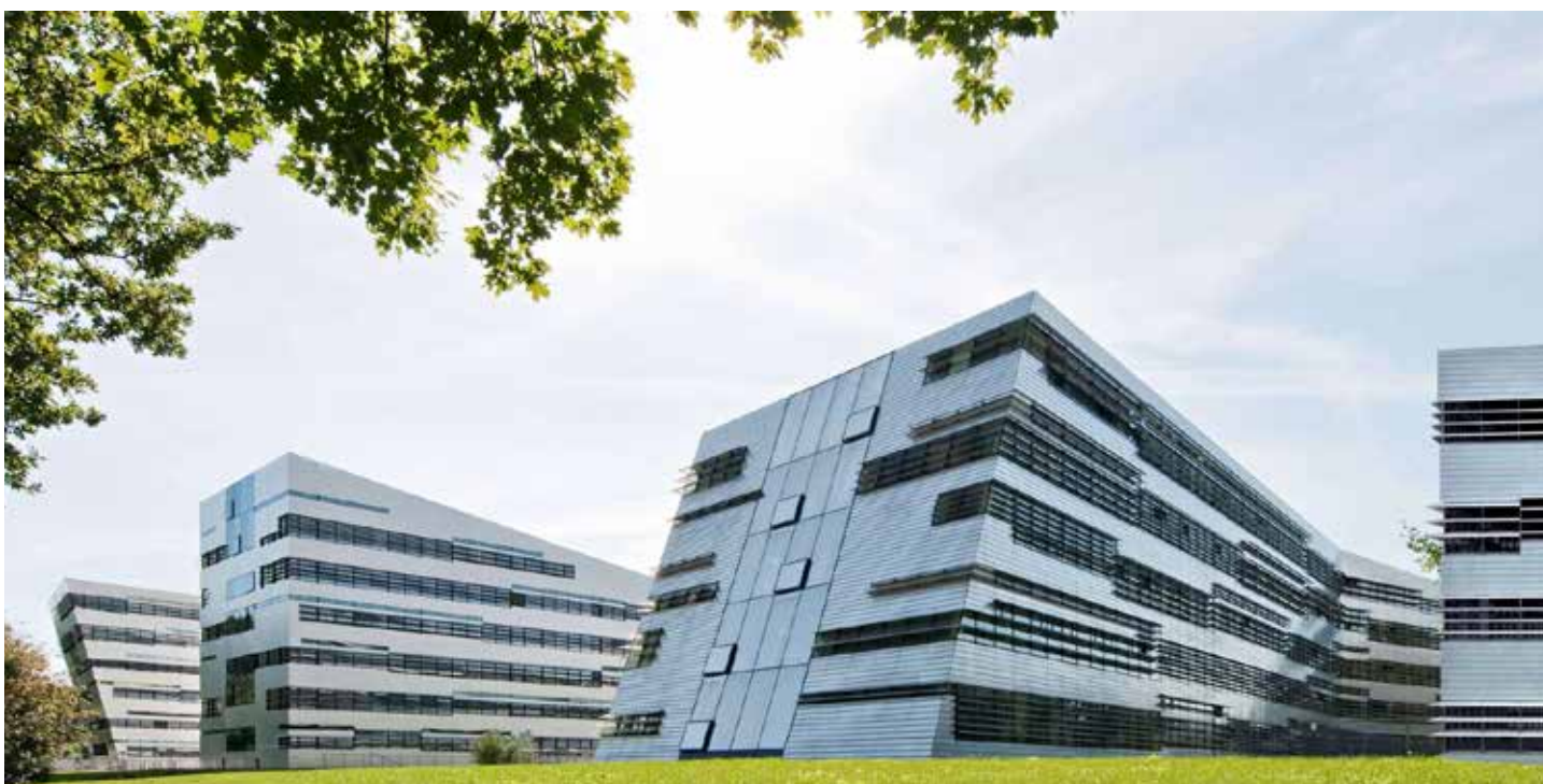
Der JKU Science Park wurde zuletzt um weitere Bauteile erweitert.
